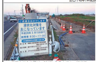
復興交付金を受け、2016年3月までの工期で行われている液状化対策の工事＝神栖市堀野地区
