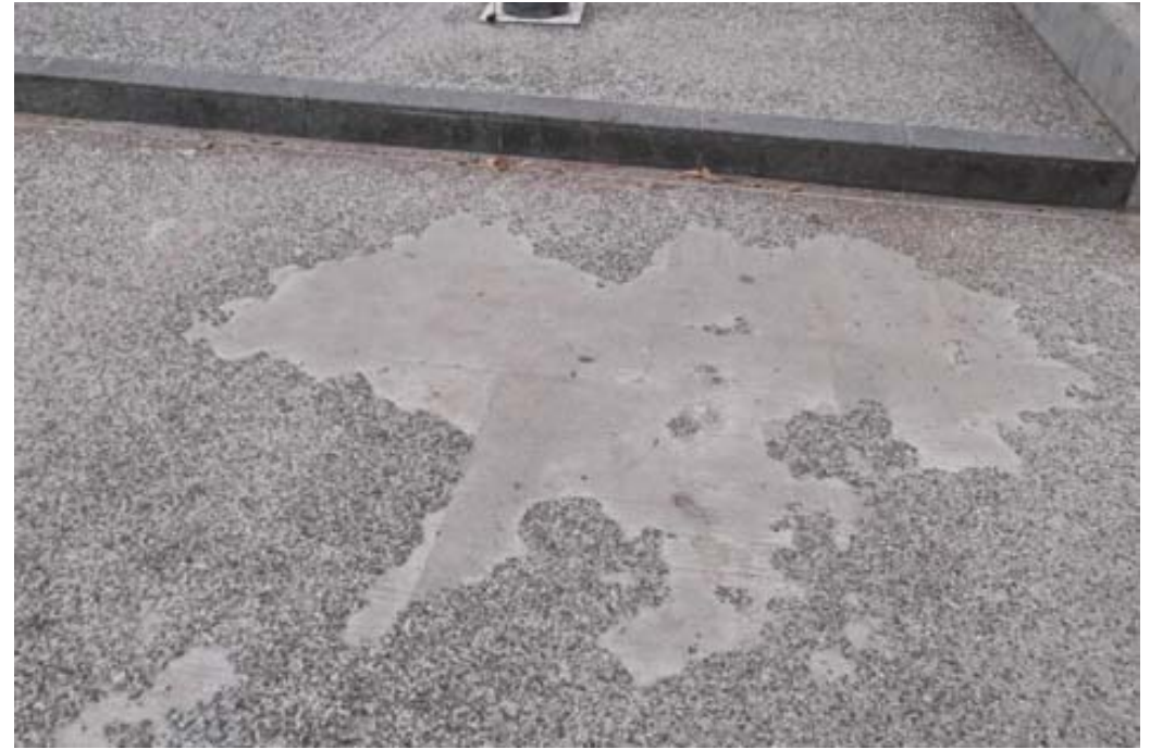
ピストバイクによる舗装面の破損
