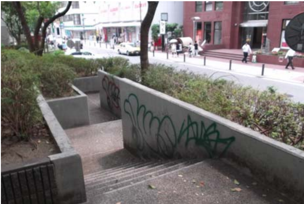
警固公園通り側通路の壁の落書き
