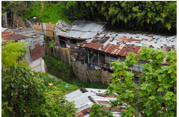
写真-8 サンホセ地区に造られた掘立小屋(筆者撮影)
