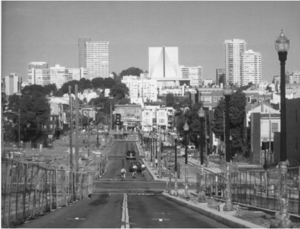
図-3 施工中の Octavia 並木通り
