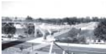
写真30,Bercy-Tolbiac Footbridge, Paris,France.(2002)
