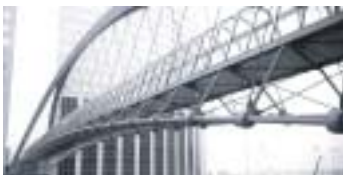
写真32,Japan Bridge, Paris,France.(1993)
