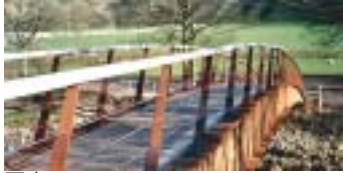
写真25,River Irthing Footbridge, Hadrian's Wall,UK.(1999)
