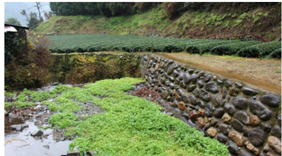
写真-3 八女市「星野川支川」
