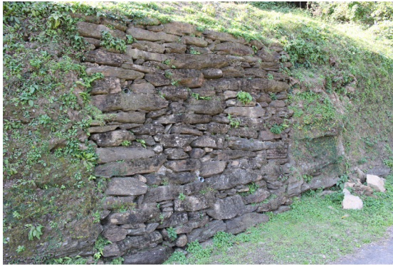
写真-7 石積み復旧現場 (平成27年度の例)
