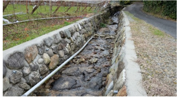
写真-2 久留米市「八幡川」
