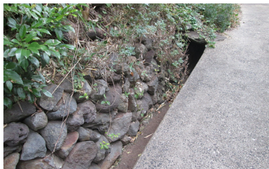
写真-10 唐見崎の石積み復旧現場
