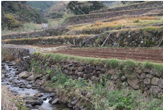
写真-8 春日集落の石積み復旧現場
