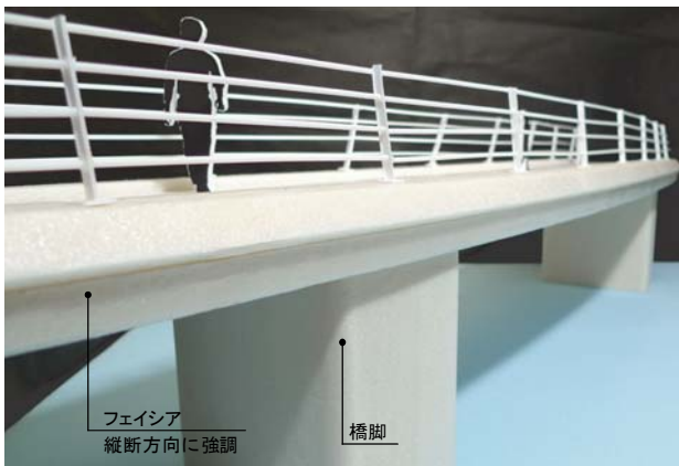
写真-1 遊歩道海域部の詳細形状 (1/20 部分模型)
