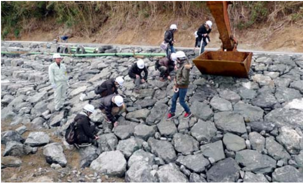
写真-11 石積み護岸における仕上げの確認
