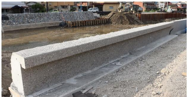
写真-11 パラペットの施工状況 (右岸側)
