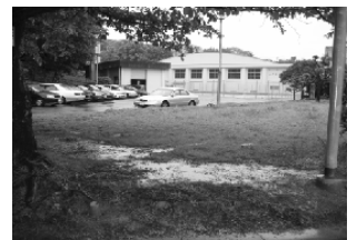
写真-4 悪化した広場内地面（奥には駐車場）
