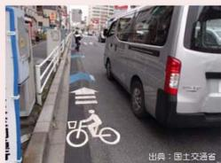
図1 車道混在型の自転車走行空間
